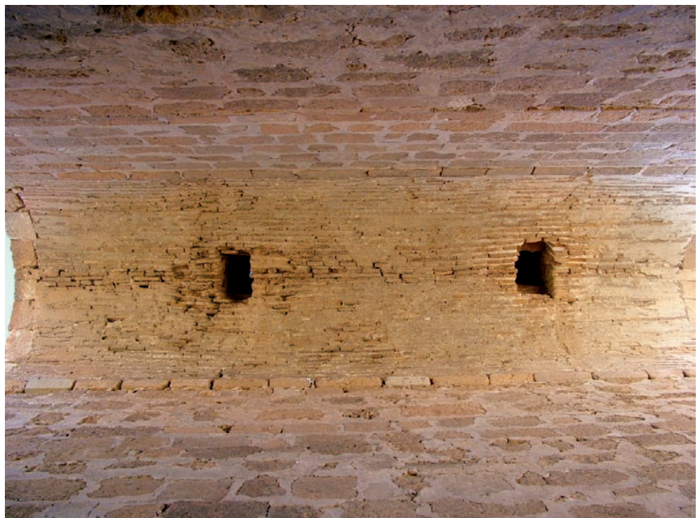
Bóveda del pasaje
