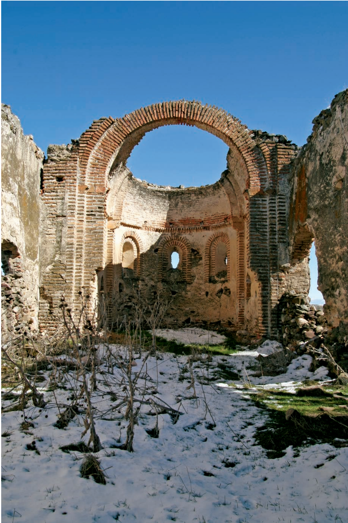
Interior de la nave
