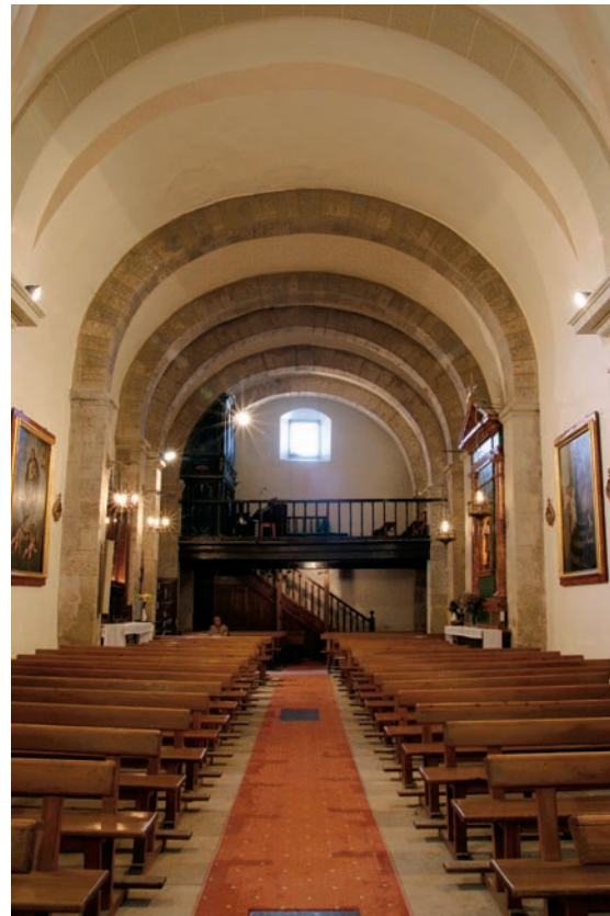
Interior de la nave vista hacia los pies
