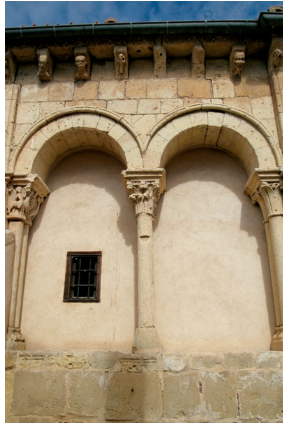
Detalle del pórtico
