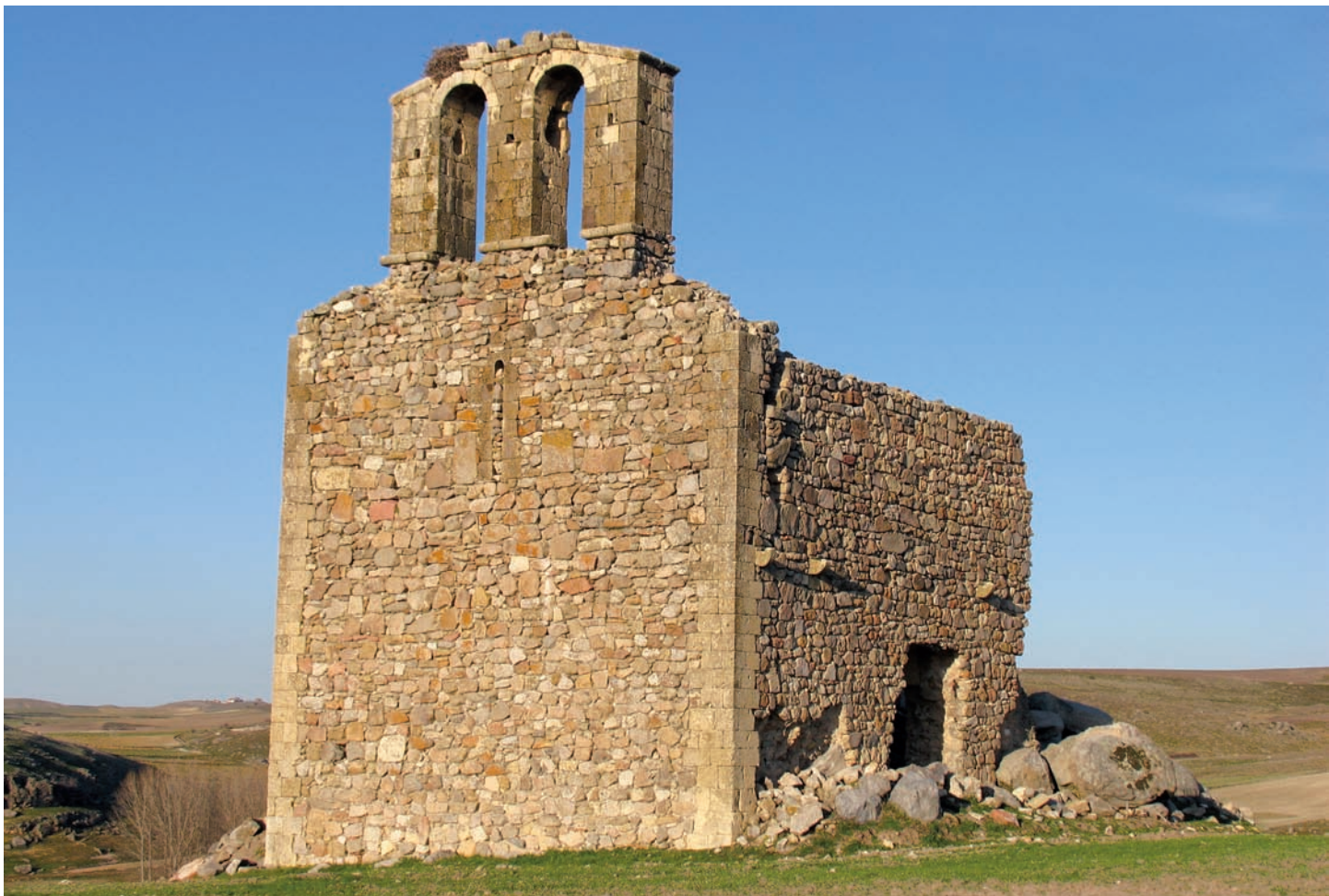
Vista general de las ruinas de San Medel
