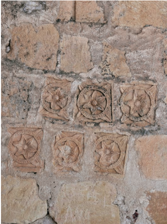
Dovelas reutilizadas en el muro del edificio
