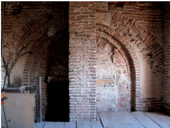
Arco cegado en la torre
