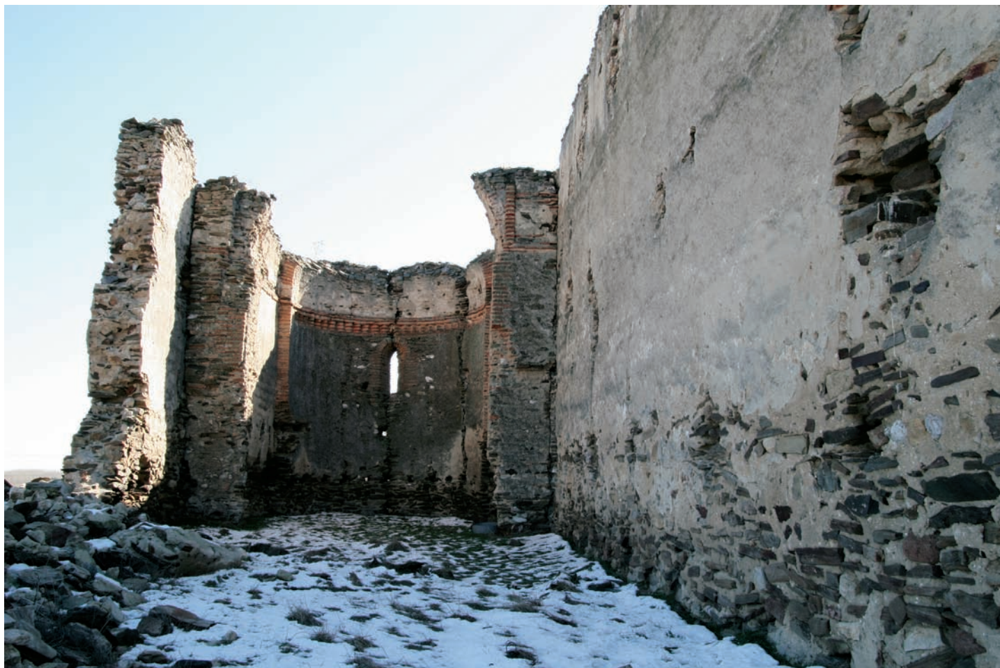
Interior del edificio
