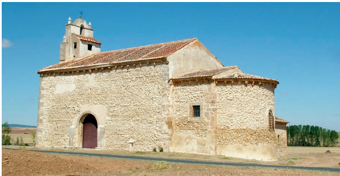
Vista del edificio desde el sudeste
