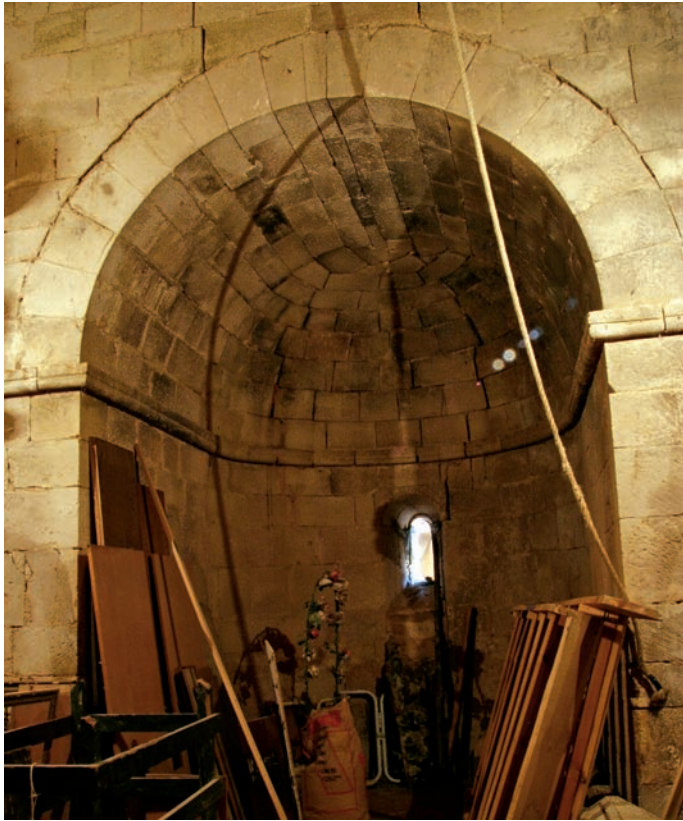
Absidiolo de la torre
