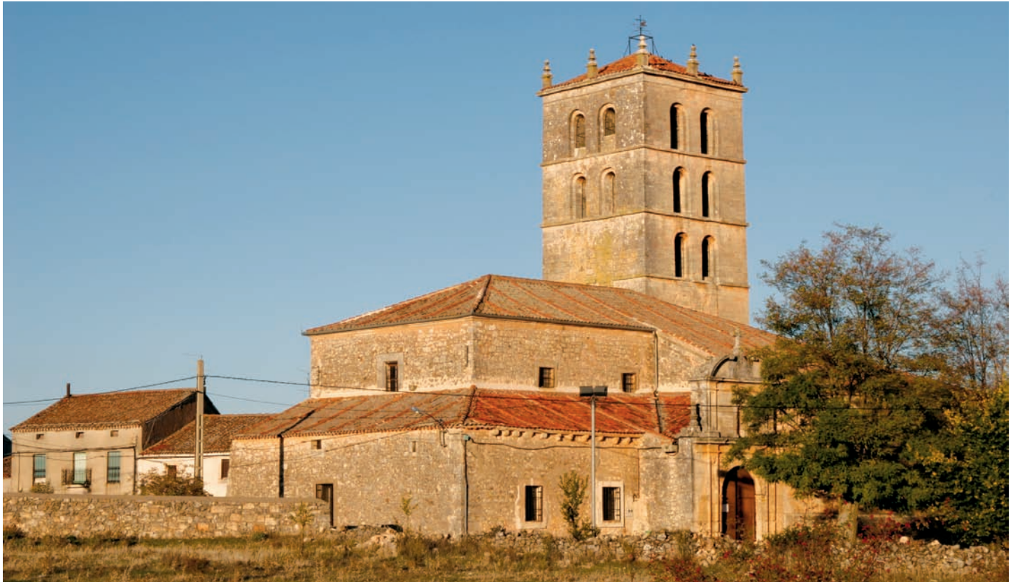
Exterior de la iglesia
