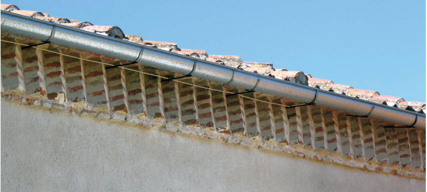
Cornisa del muro norte de la nave
