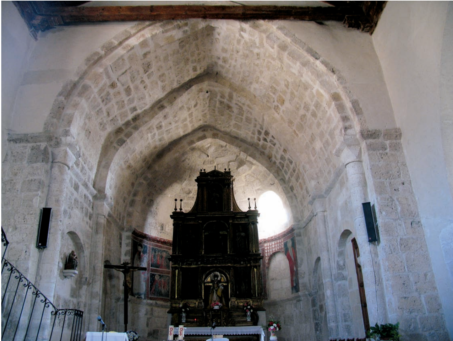
Interior del ábside
