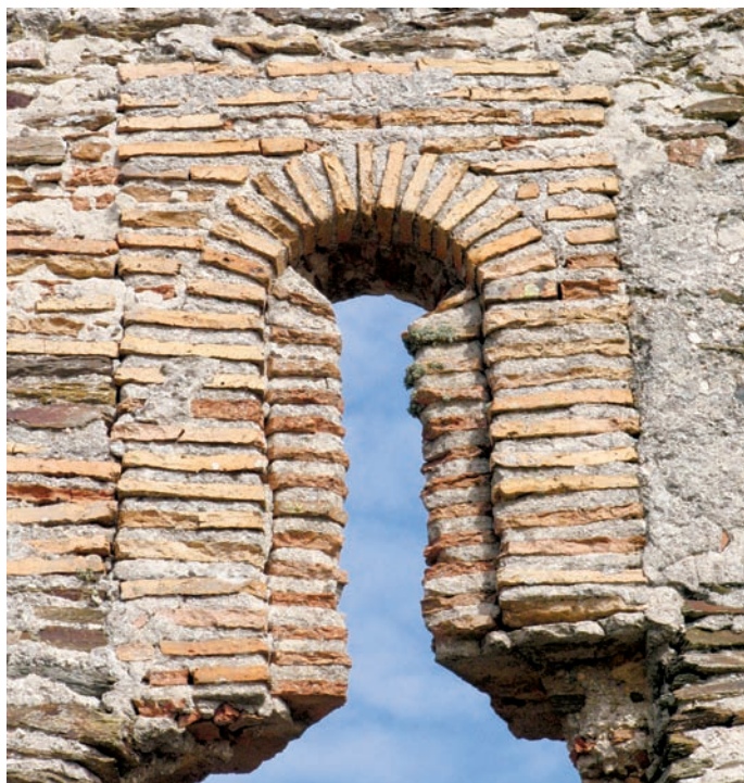
Ventana del bastial occidental
