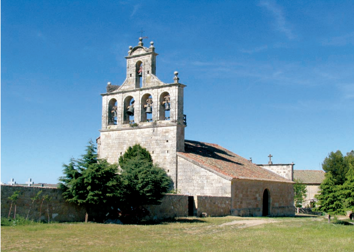
Vista del edificio desde el oeste
