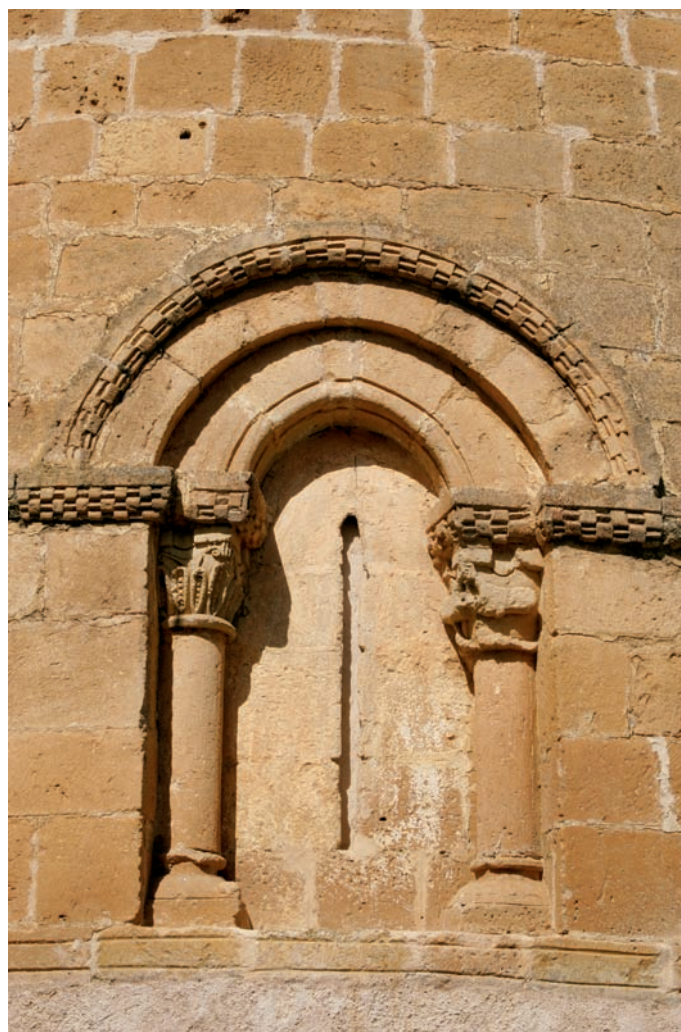
Ventana central del ábside
