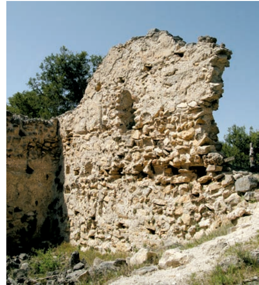
Vista del hastial occidental
