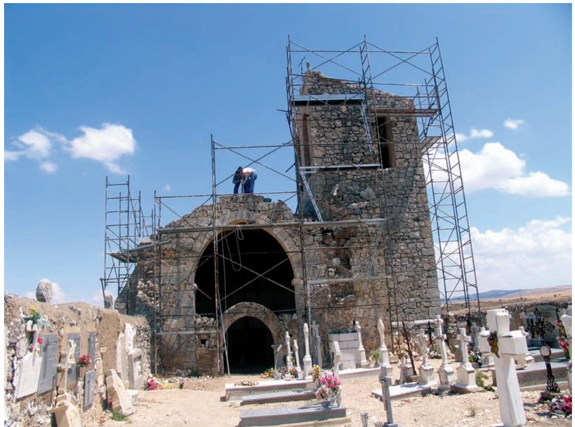
Exterior durante la restauración
