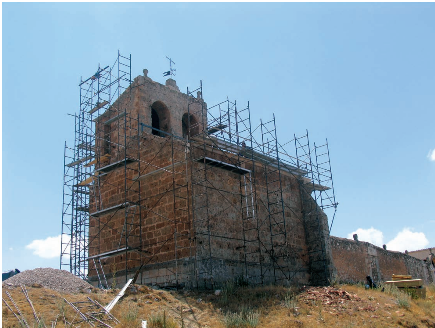
Ermita del cementerio. Exterior durante la restauración
