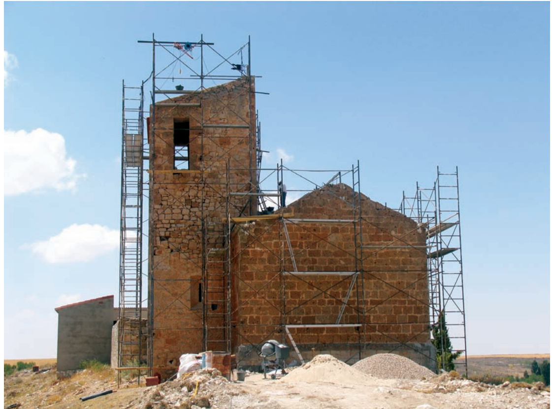
Exterior durante la restauración
