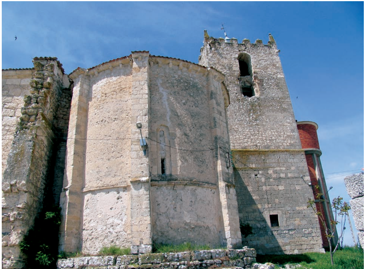
Exterior del ábside y de la torre
