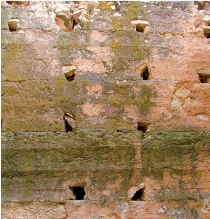
Restos de mechinales en el interior
