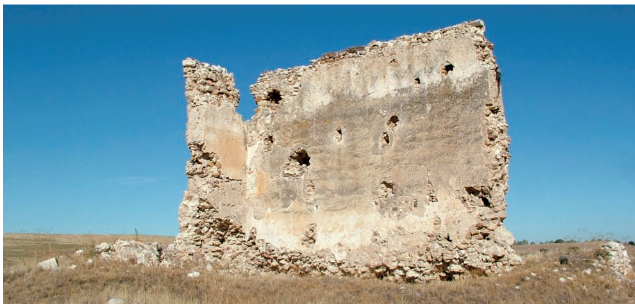
Restos del muro sur
