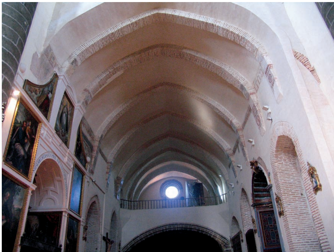
Interior de la nave
