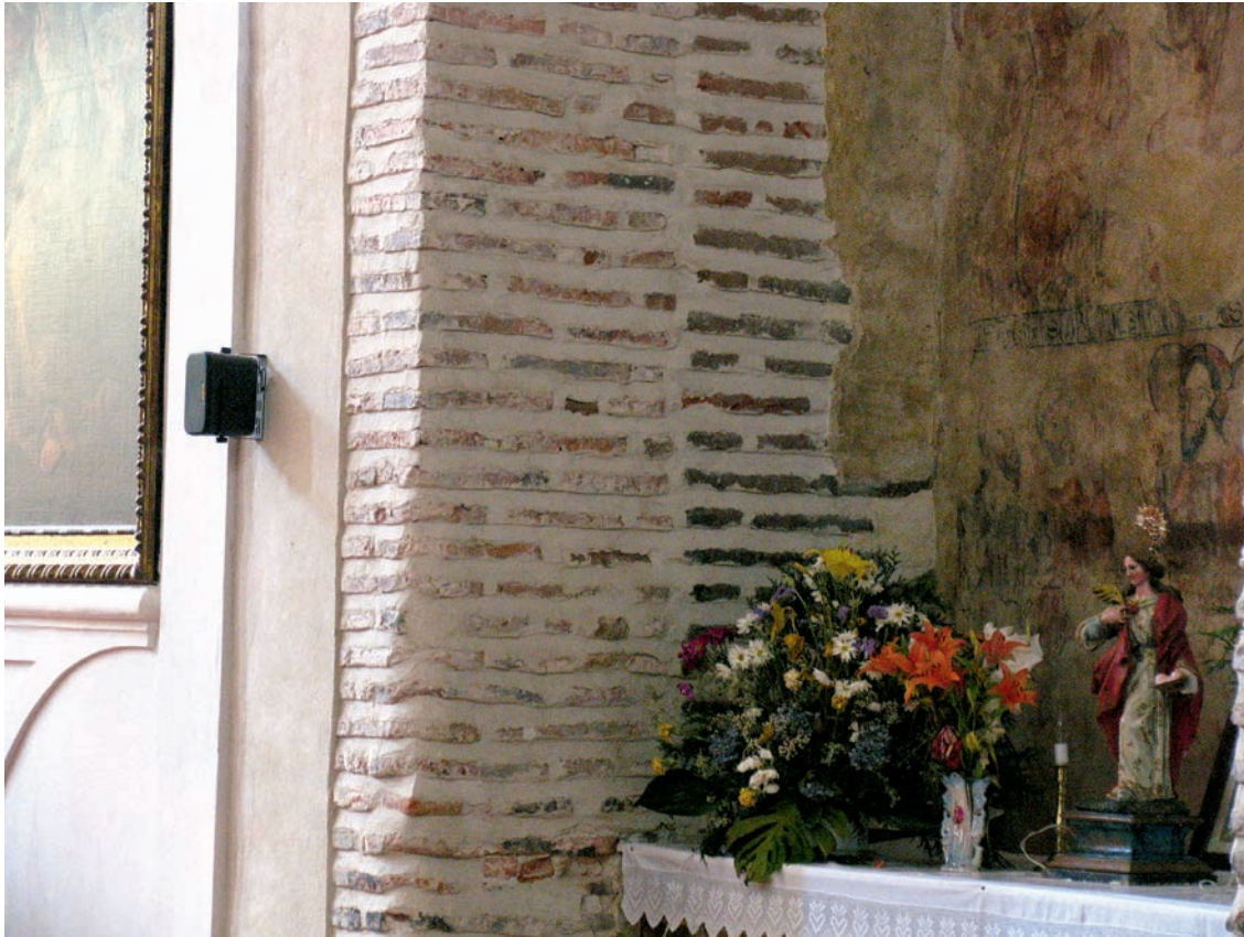
Muestra de las distintas bojas que corresponden a diferentes momentos constructivos.
