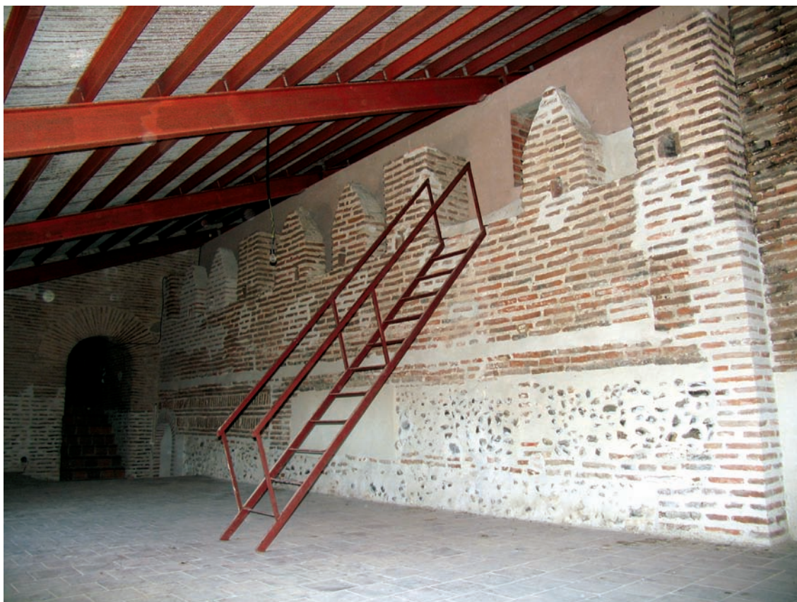
Restos del almenado del muro meridional
