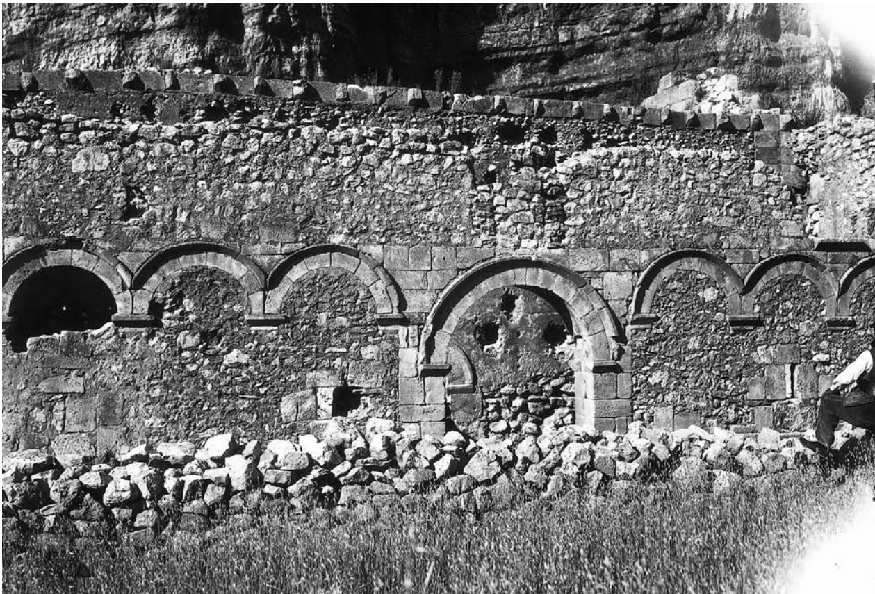
Fachada meridional con el desaparecido pórtico. Fotografía de 1975 (col. Antonio Ruiz Hernando)
