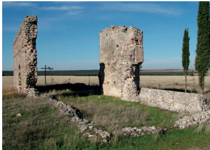
Interior de la ruina
