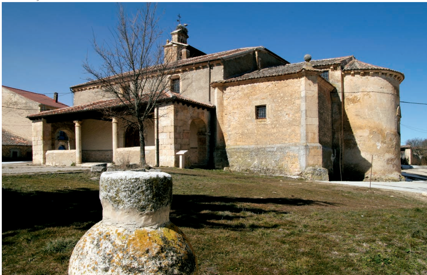
Exterior de la iglesia
