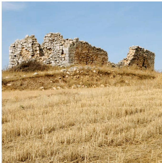
Piso bajo de la torre
