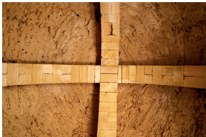
Bóveda de la torre
