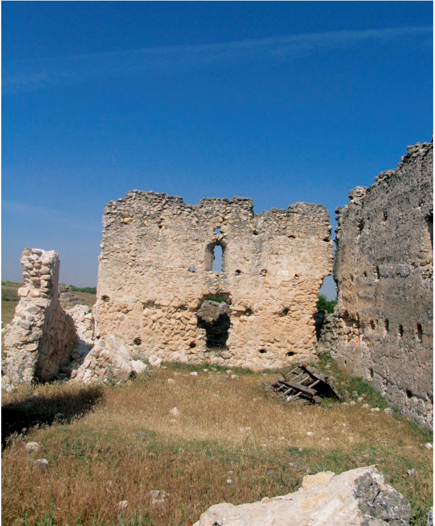
Vista del interior hacia el bastial occidental
