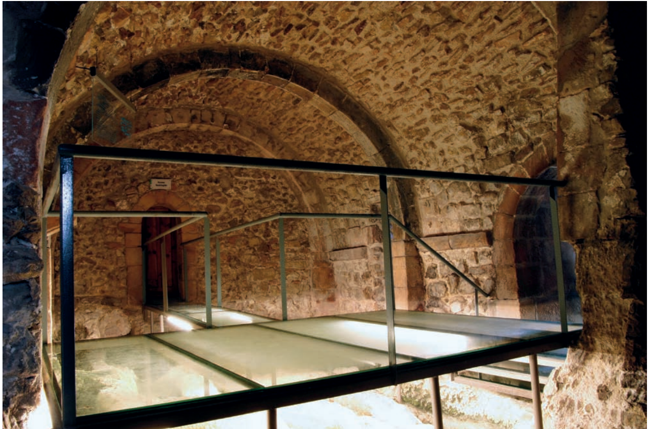
Interior de la cripta hacia el este
