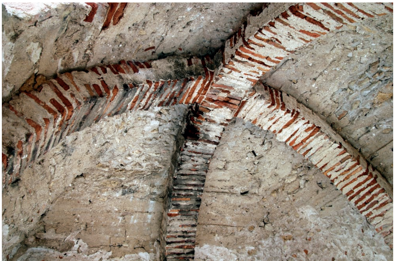
Bóveda del piso alto de la torre
