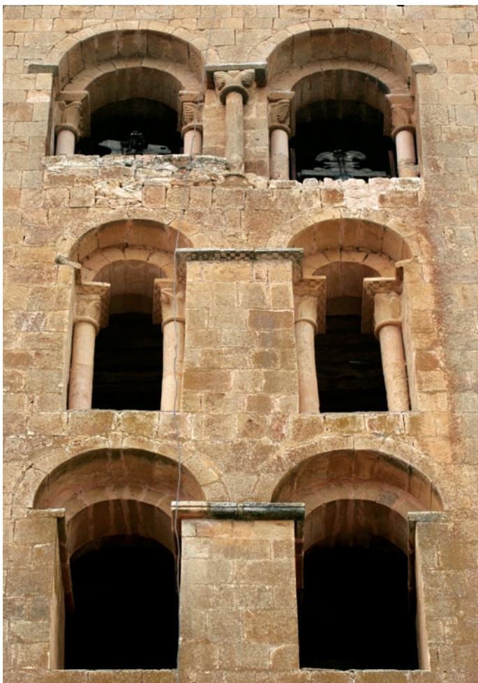
Detalle de la torre
