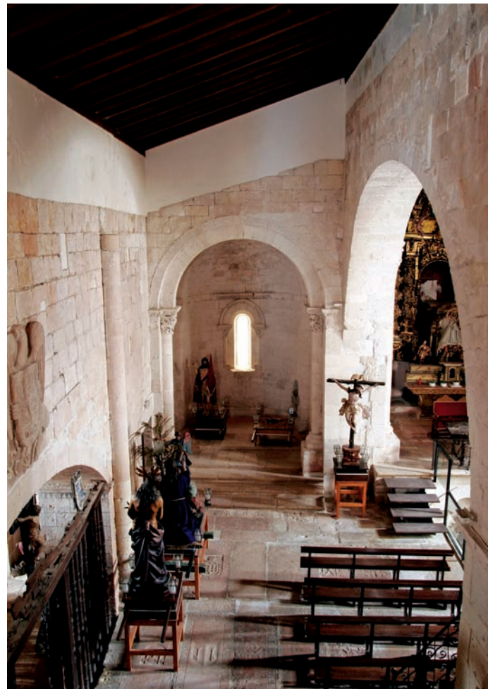
Interior de la nave del evangelio
