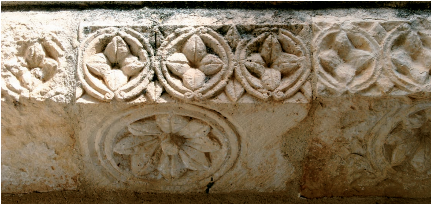
Detalle de la cornisa
