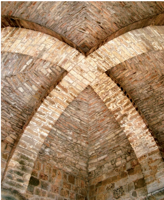
Bóveda del piso alto de la torre
