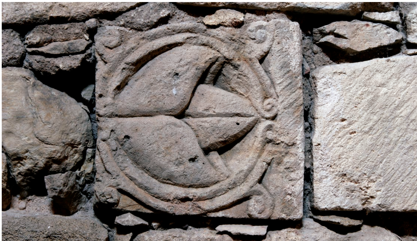
Dovela con lirio reutilizada en el interior de la torre
