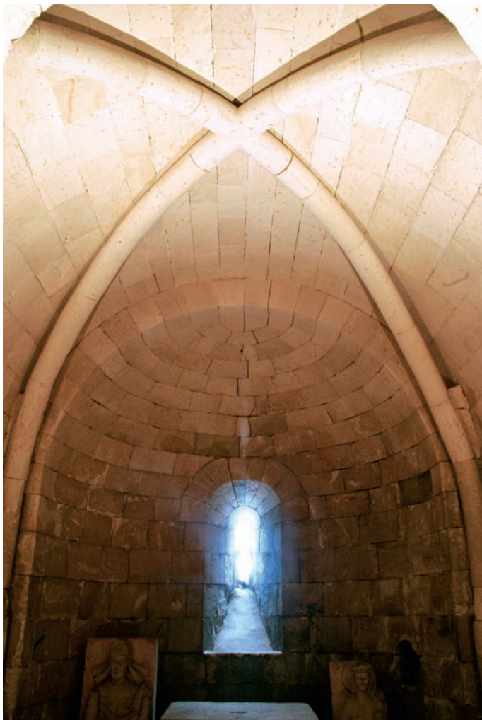
Interior de la cripta
