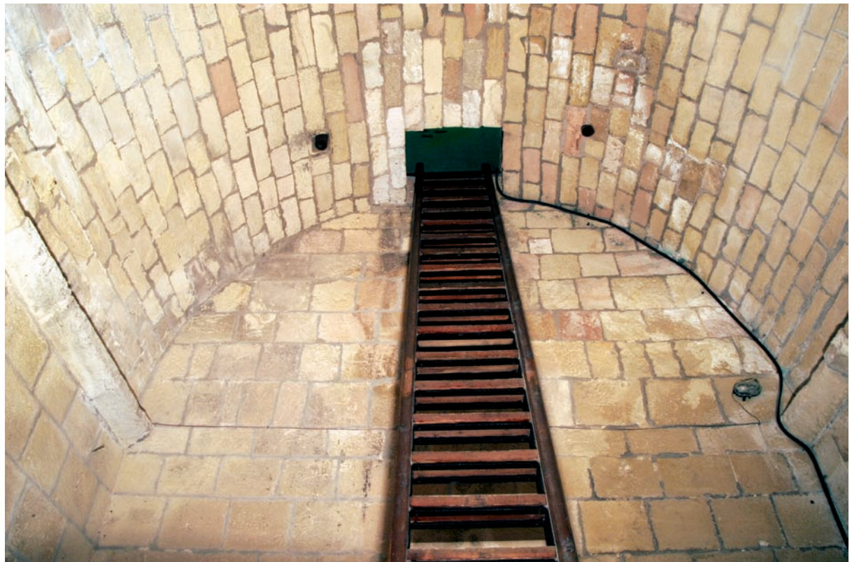
Bóveda del piso medio de la torre
