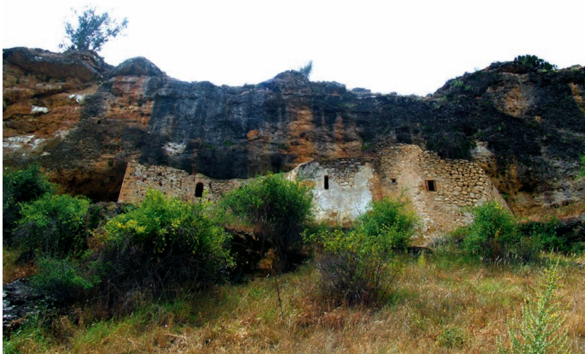
Ermita de "Santiaguito". Vista general
