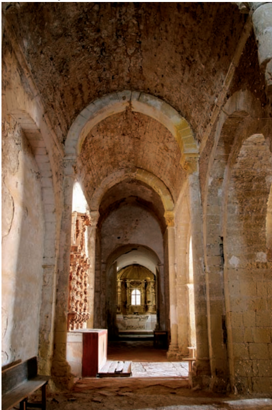
Nave del evangelio
