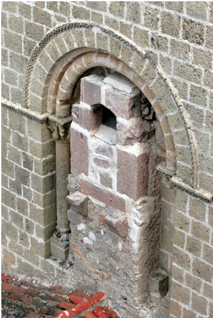
Muro occidental de la torre de la iglesia
