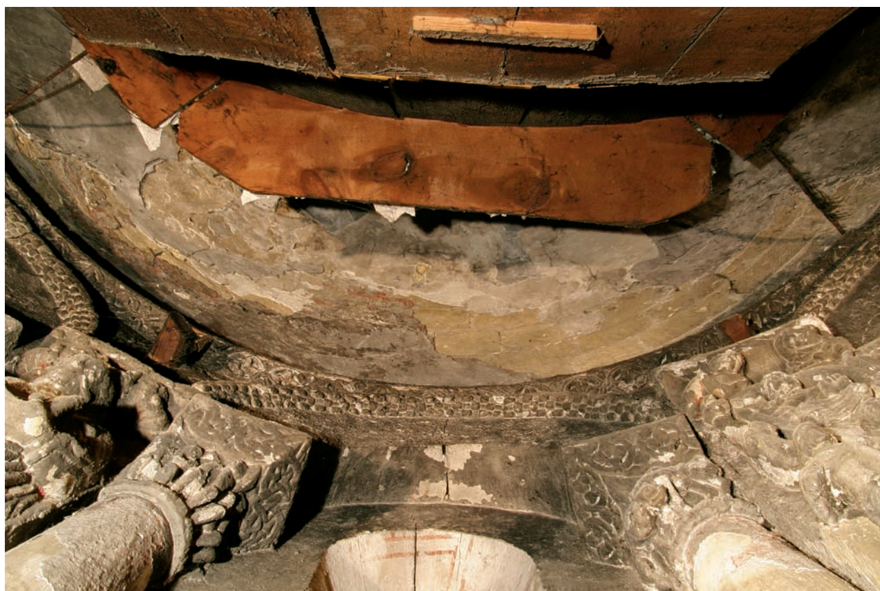
Interior del casarón absidal
