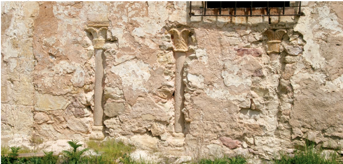
Exterior de la galería porticada
