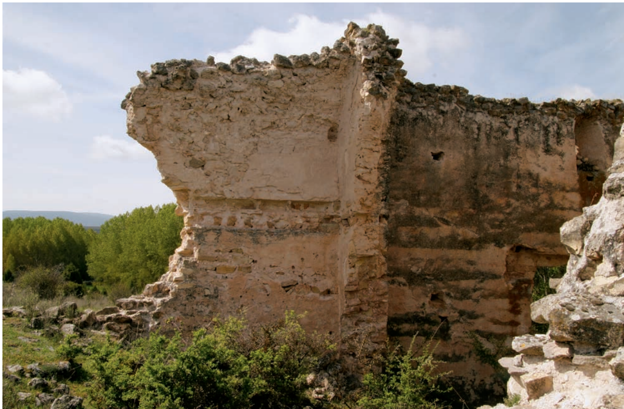
Detalle del interior
