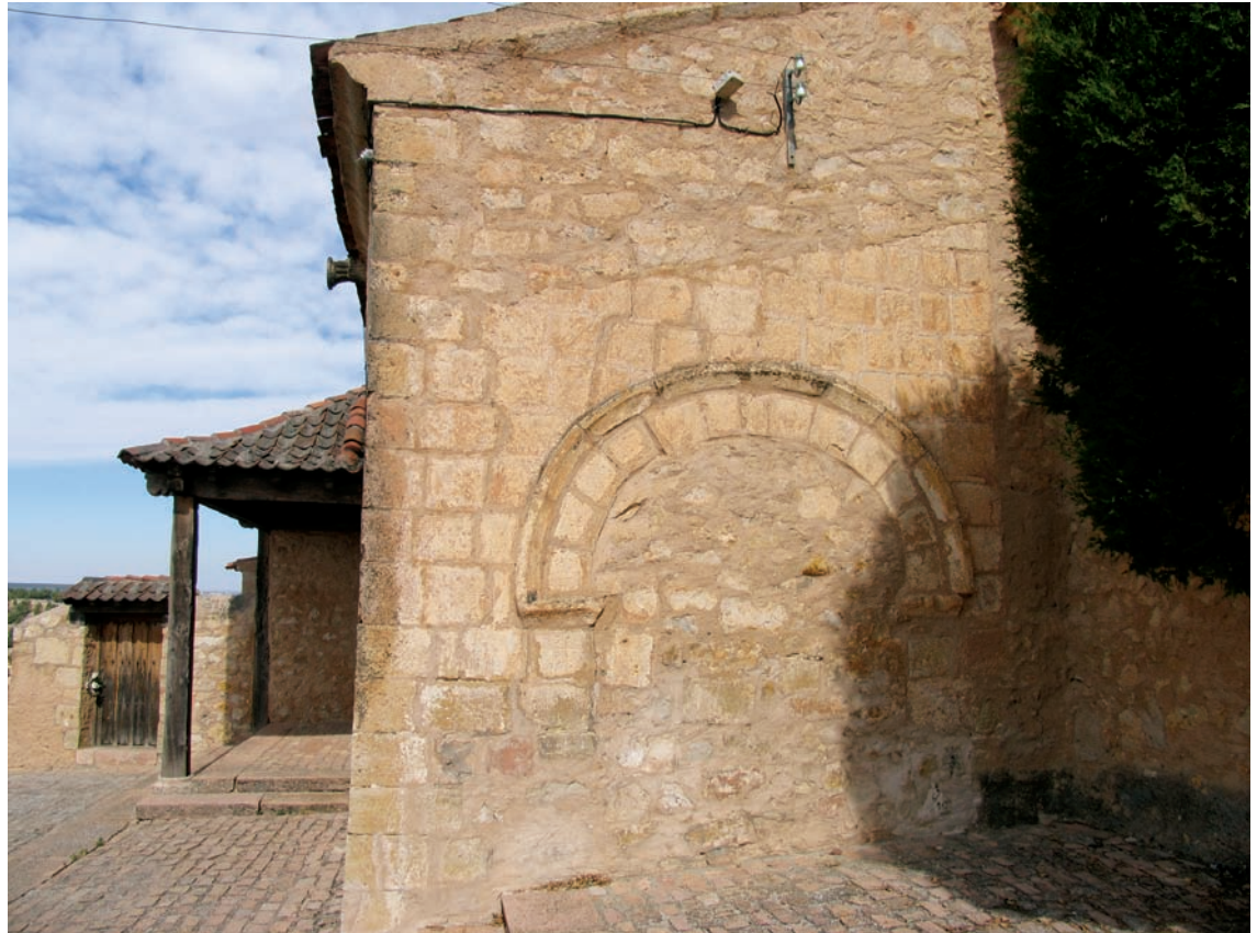
Restos de arco cegado en la parte oriental
