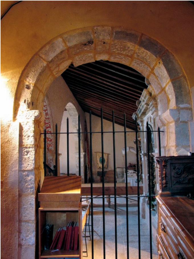
Interior del ábside norte hacia la nave
