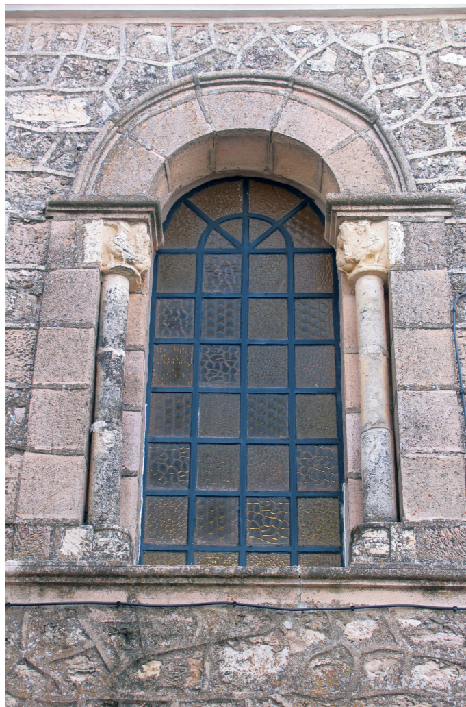
Ventana en el muro oeste
