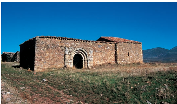
Exterior desde el lado sur
