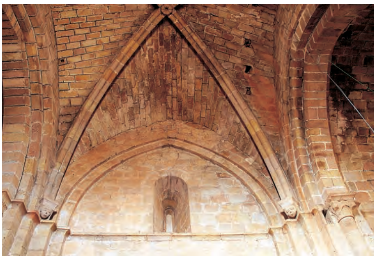
Bóveda y muros de la iglesia de Fuensaúco
