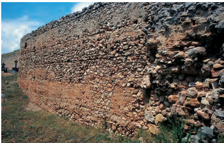
Encofrado de la ermita del cementerio de Gormaz
