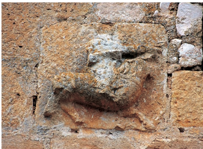
Jinete de la fachada meridional
