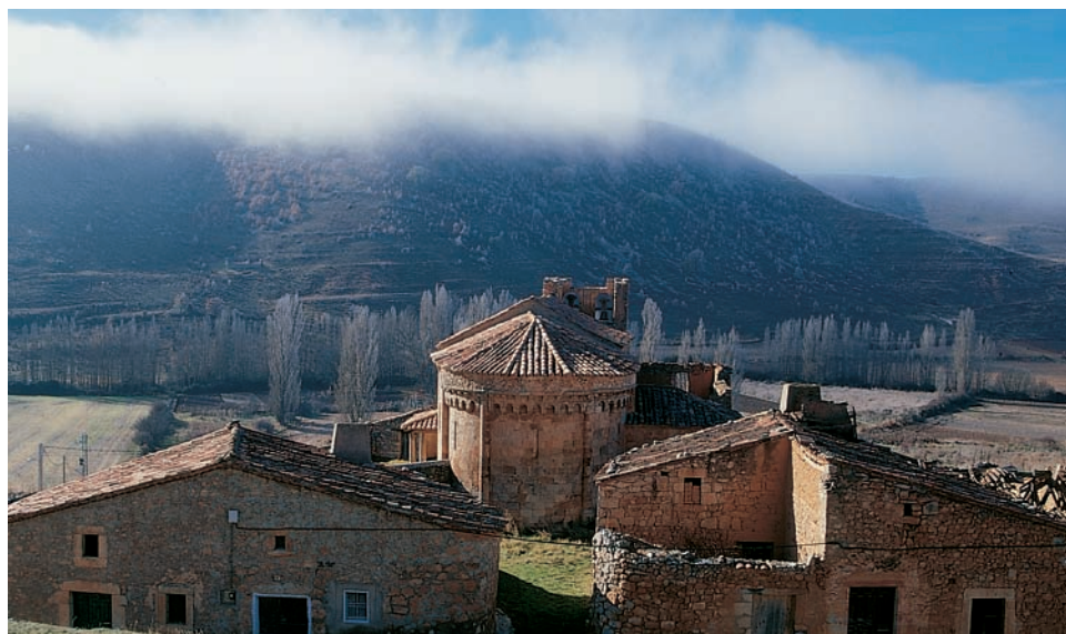
Vista general desde el este
