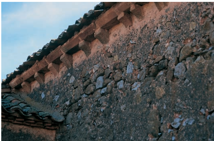
Alero del muro norte
