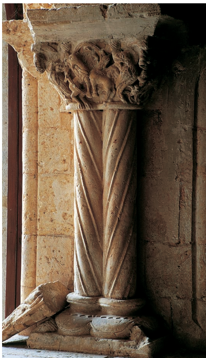
Arquerías de la sala capitular
