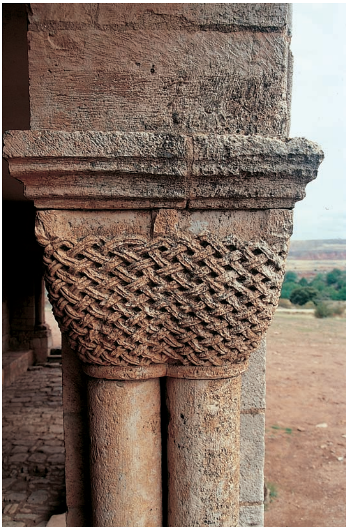
Capitel del pórtico con entrelazos
