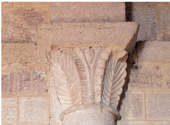
Capitel de la nave
