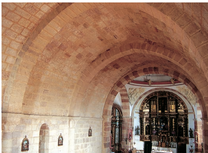
Bóveda de la nave
