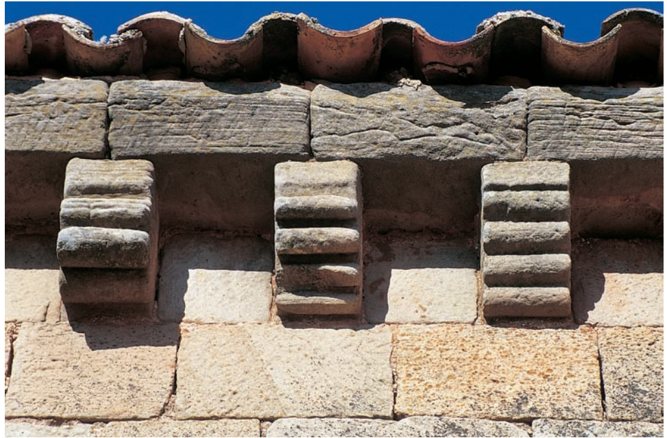
Canecillos del muro sur de la nave
