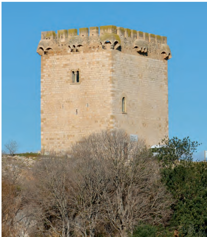
Panorámica del emplazamiento
