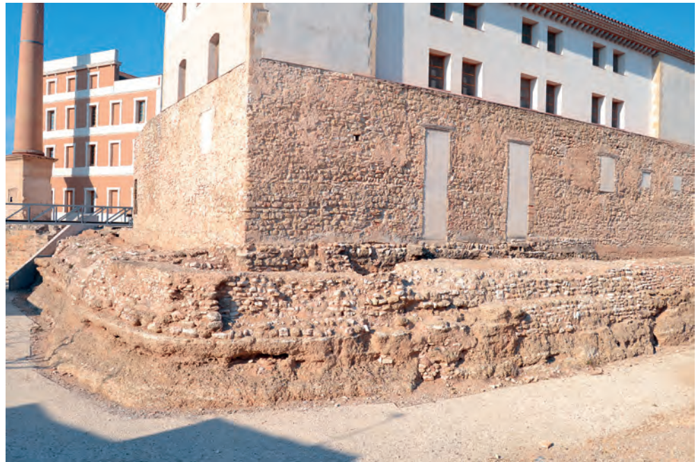
Restos del muro y del primer foso
