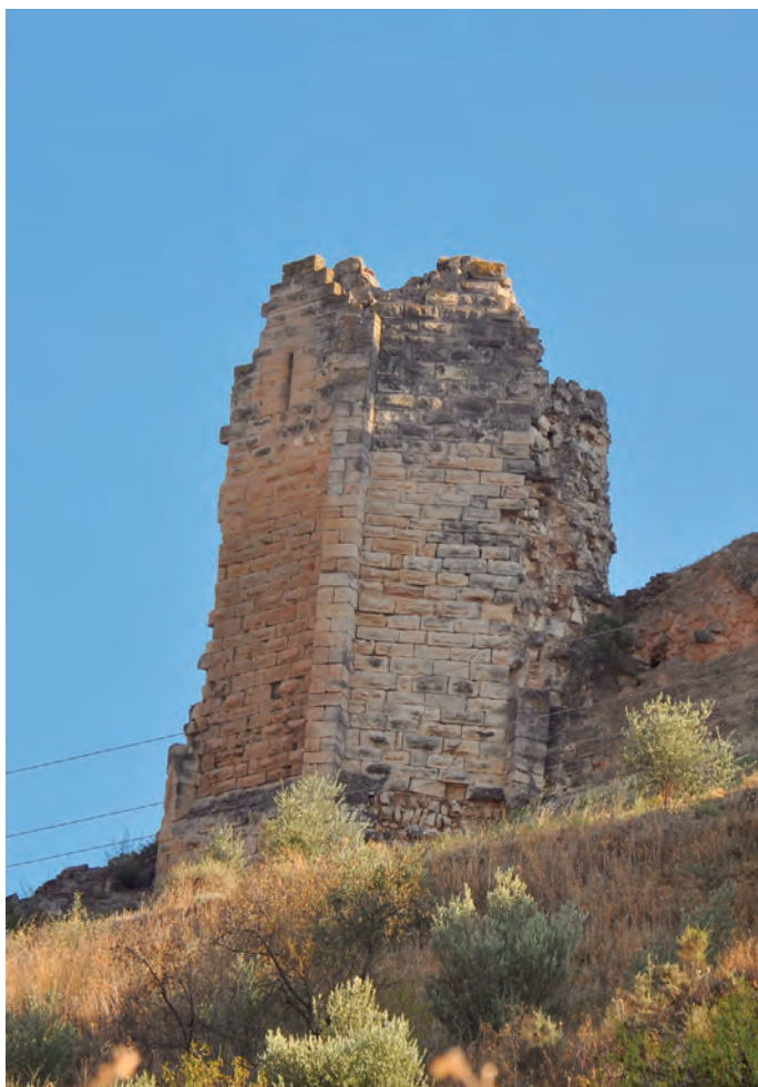
Torre de vigilancia
