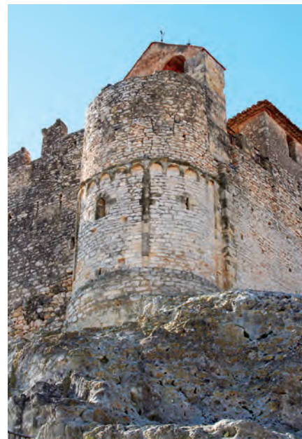
Ábside de la iglesia de la Santa Creu
