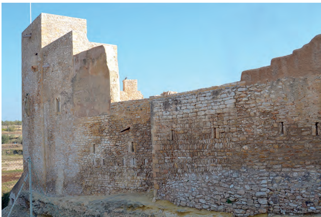
Vista del muro norte
