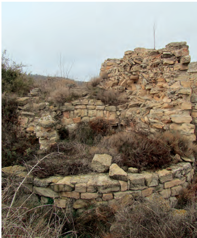
Restos de la torre
