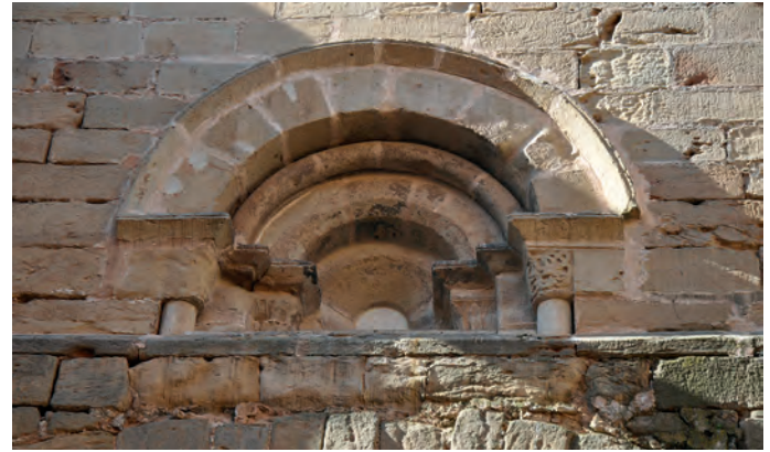
Ventana del muro norte
