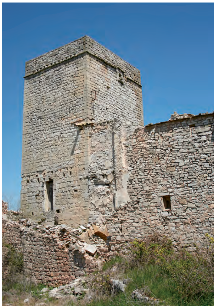
Vista de la torre
