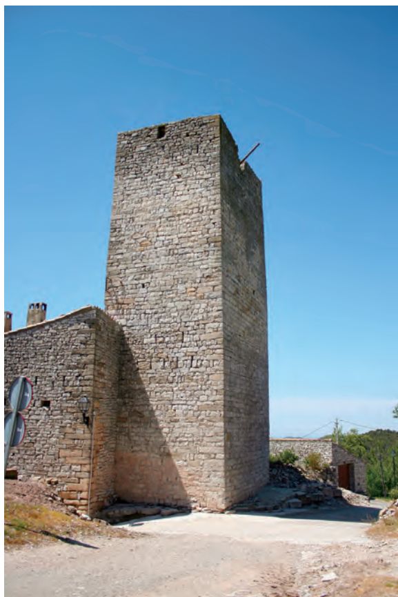
Vista general Puerta de acceso
