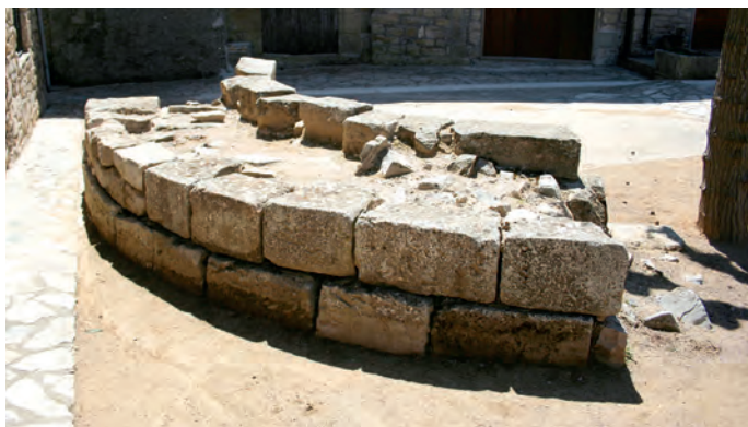
Restos del ábside
