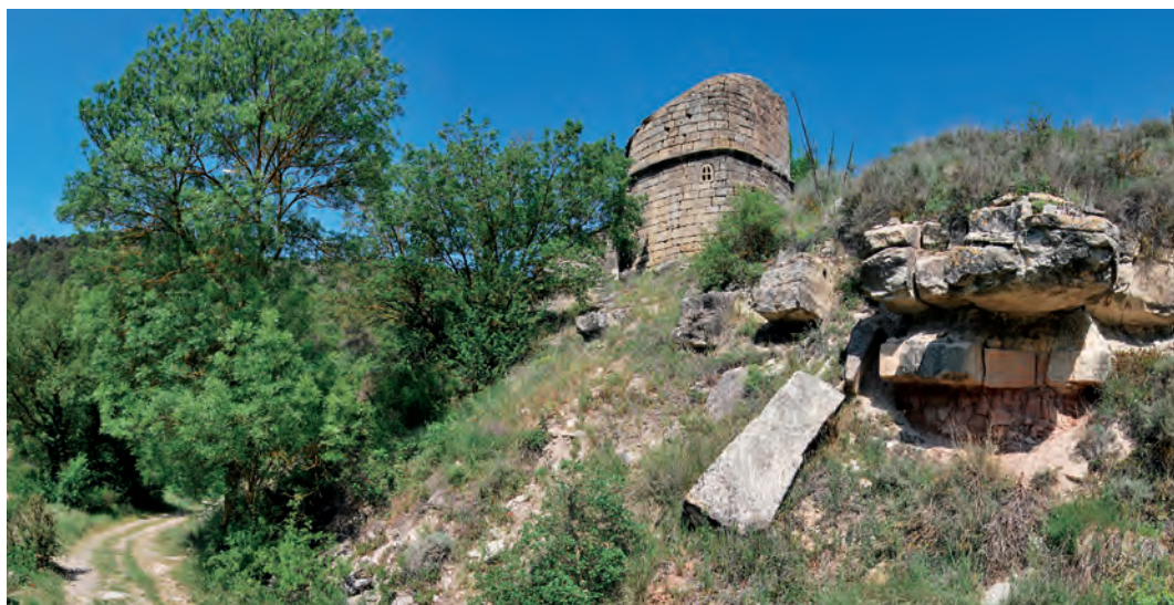
Panorámica del emplazamiento
