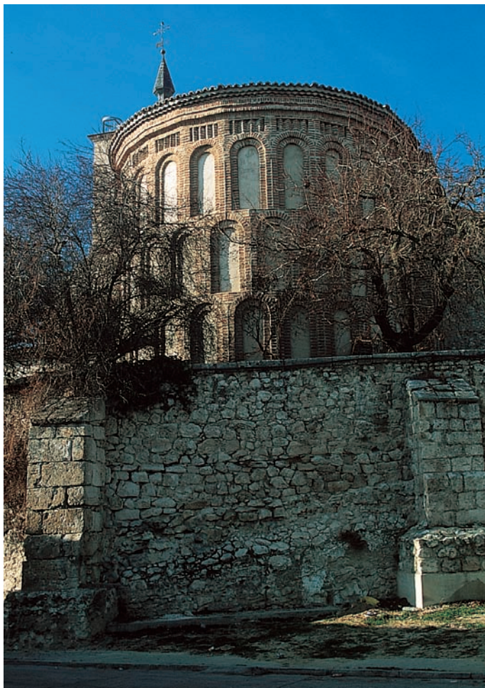
Vista general de la cabecera
