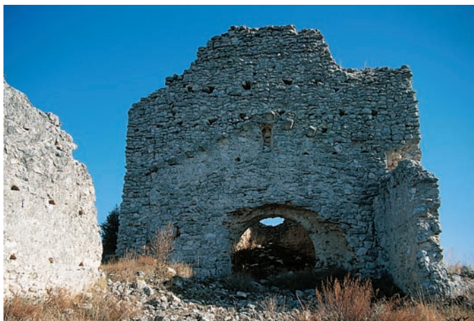
Muro occidental de la cabecera
