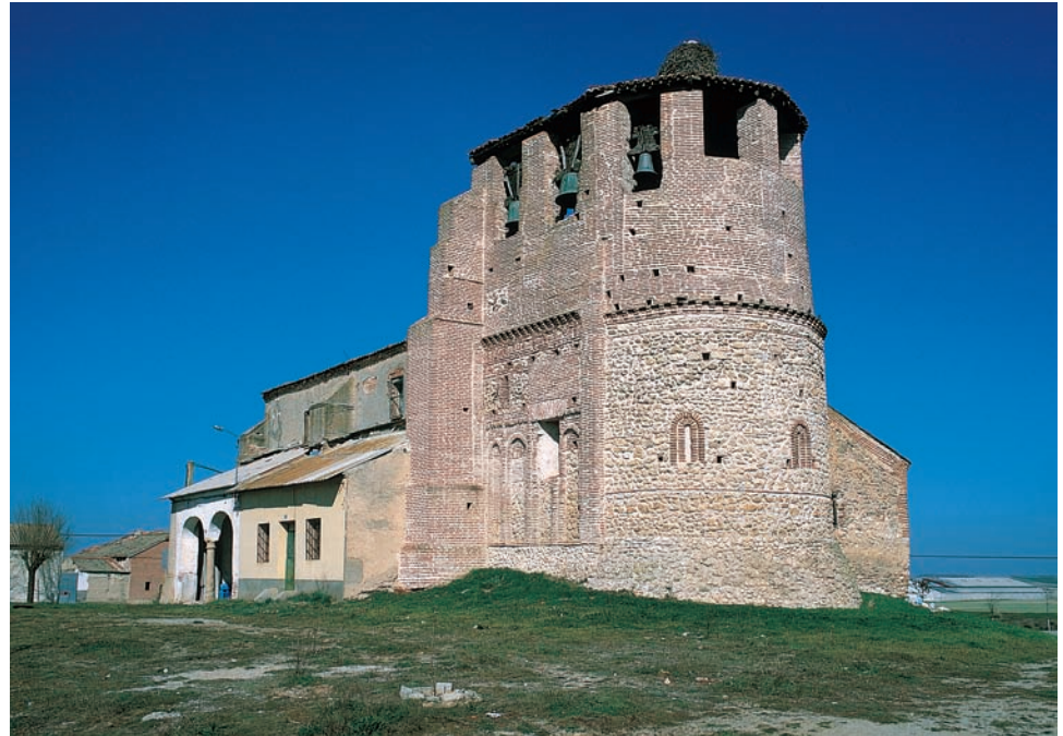
Vista general desde el sureste
