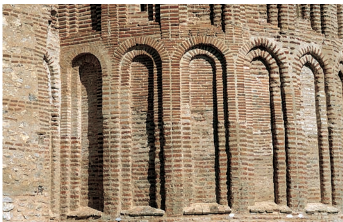
Arquerías de la cabecera
