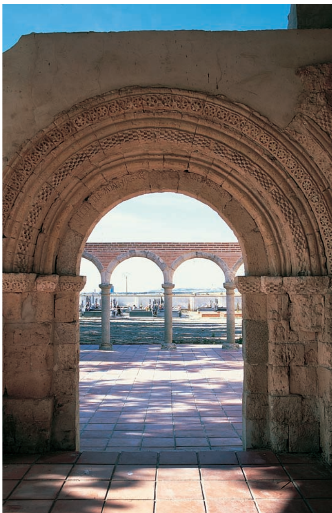
Antigua entrada a la nave
