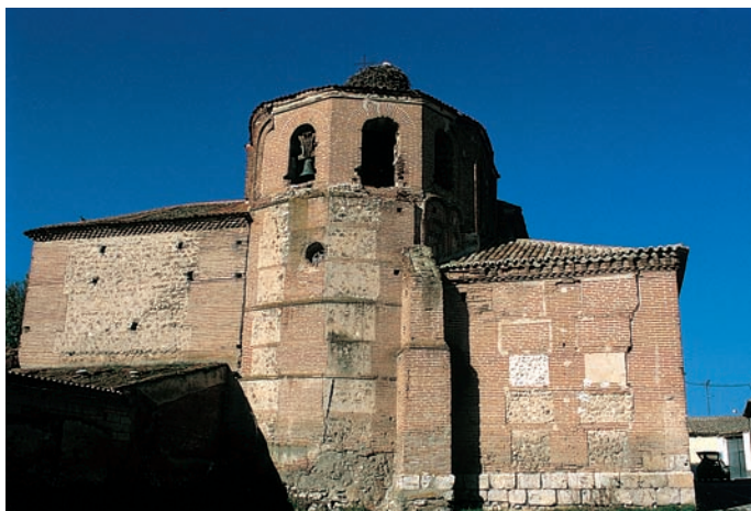
Vista general de la cabecera
