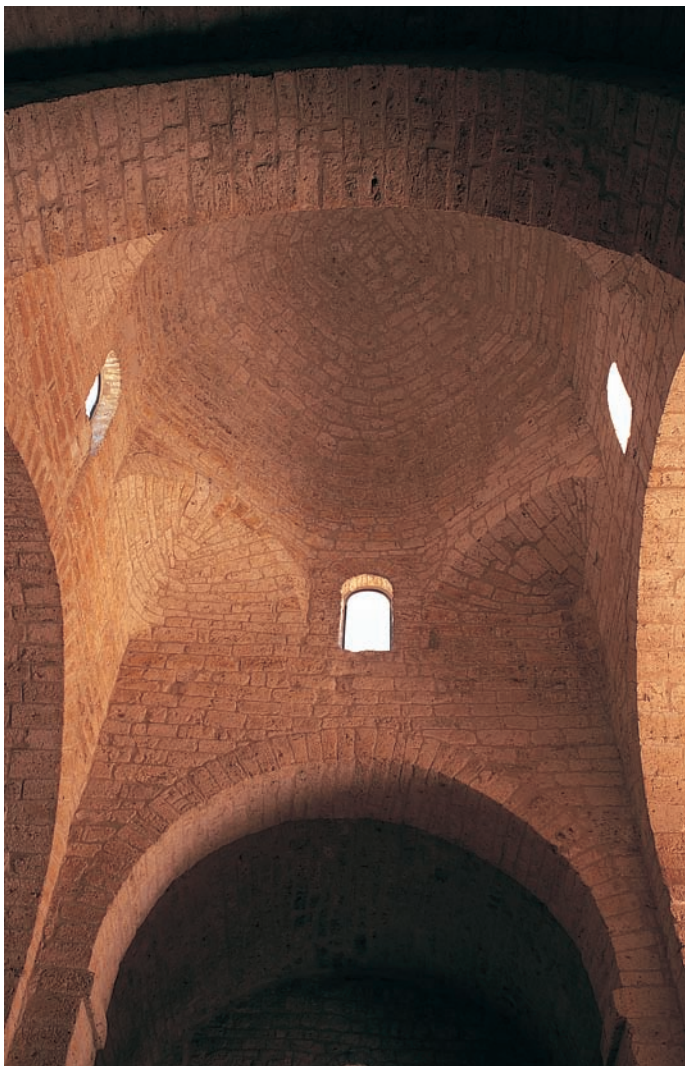
Cúpula sobre el crucero
