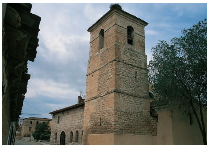
Vista general desde el sureste
