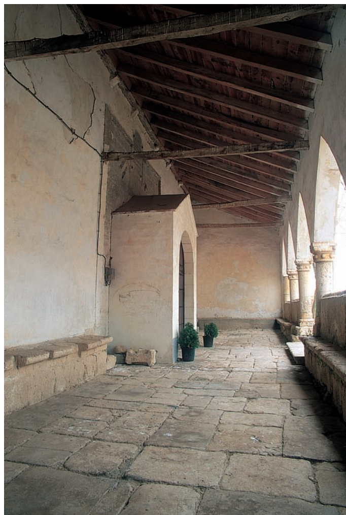
Muro septentrional de la nave
