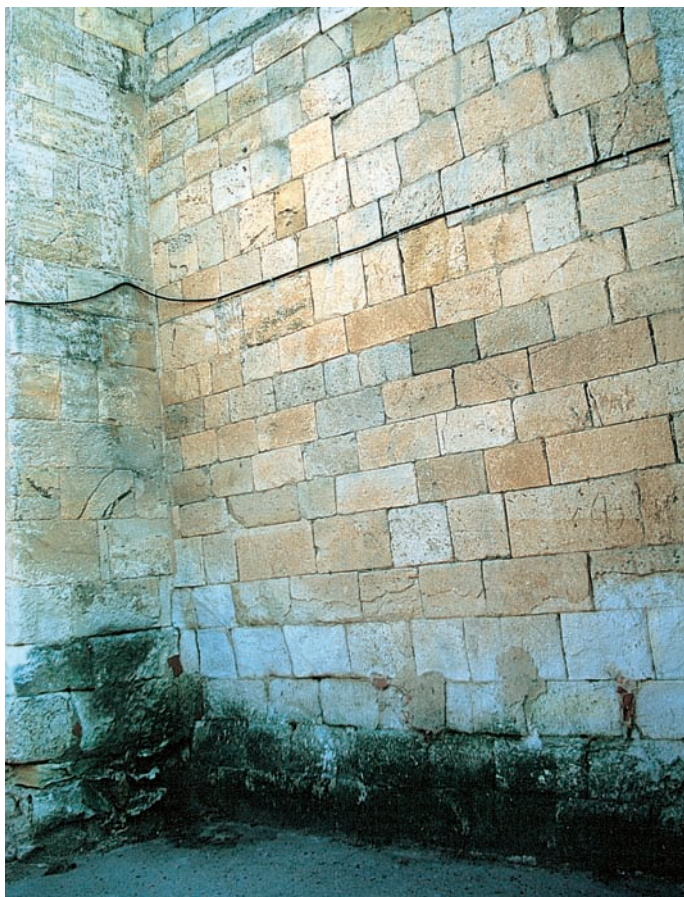
Paramento románico de la nave
