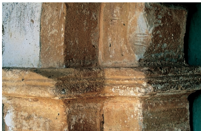
Detalle de la línea de imposta
